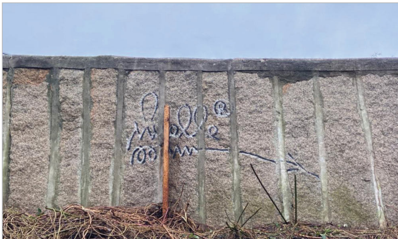
Figura 1.- Aspecto del paramento y de la firma antes de la intervención.
