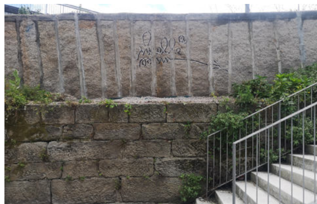
Figura 8.- Imagen final, una vez retirado el andamio.
